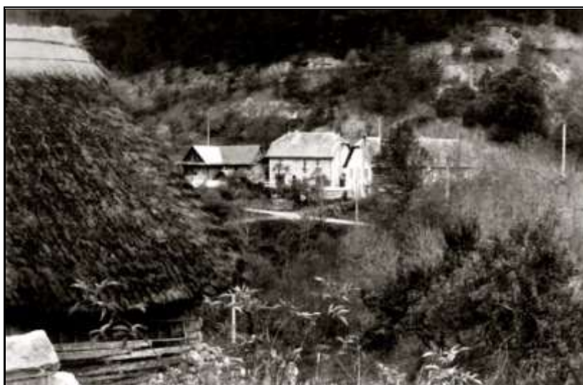
Maison et scierie COTTE vue des Pellas (photo GVHP)
